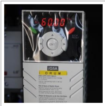
부품명 : 인버터(Inverter) 모델 : iG5A 교환주기 : 2년
